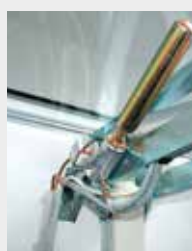
teplotní spouštěč pro automatické otevření pneu-
